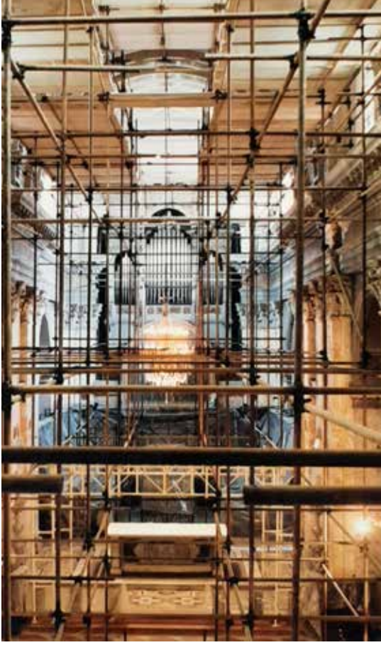
الاسكالات الضخمة التي نصبت من أجل الوصول الى اماكن التلف بسهولة وامان
